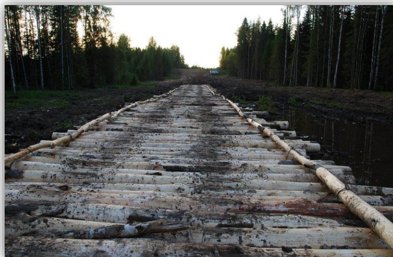
Рисунок 4.16. Дорожный переход из брёвен на заболоченном участке
