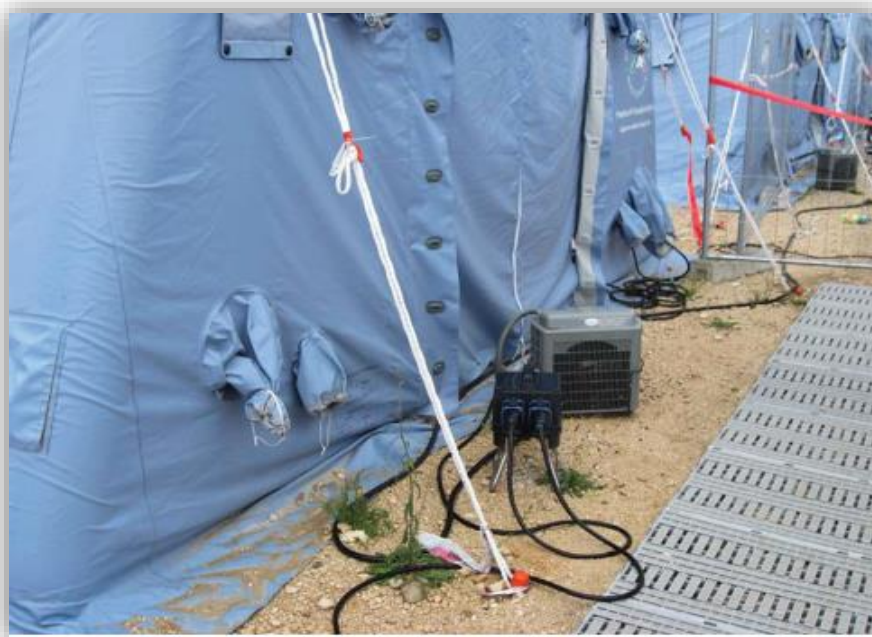
Рисунок 6.3. Индивидуальная выносная инверторная система многоместной палатки
