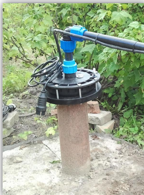
Рисунок 4.9. Водозаборная скважина с герметичным оголовком
